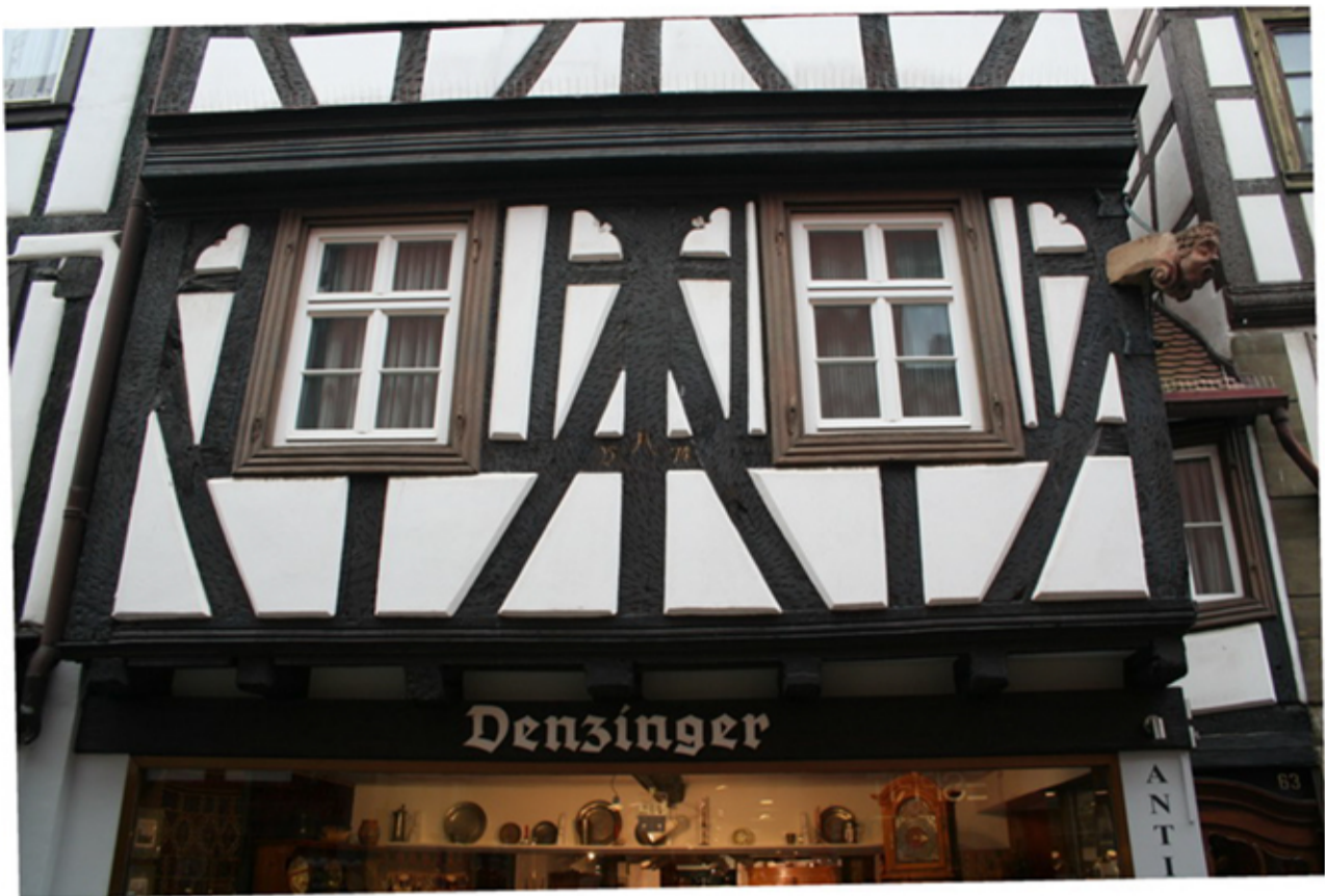
Das Denzinger-Haus in der Neustadter Hauptstraße- eines von sechs ältesten Häusern in der Pfalz. Foto: privat
